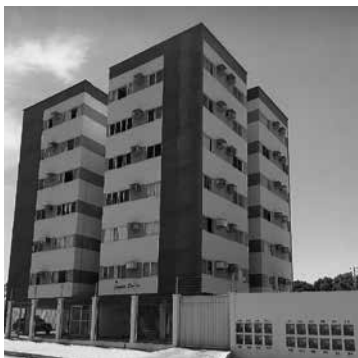
Edifício construído por mim aos 77 anos, na Rua Jesus Tomaz Tajra
